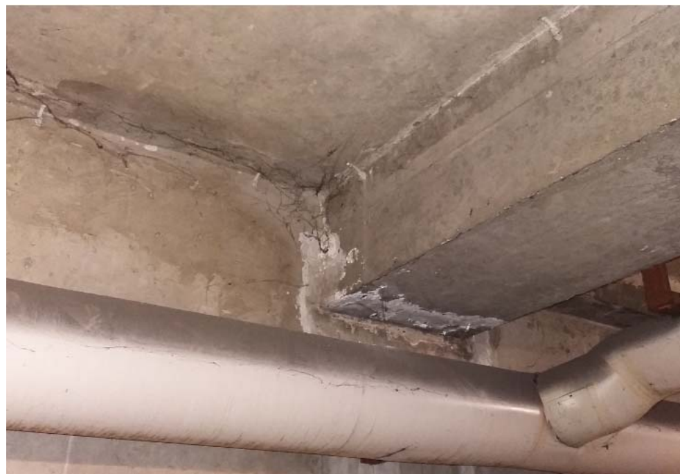
Constats de formation de calcite suite aux infiltrations d'eau
