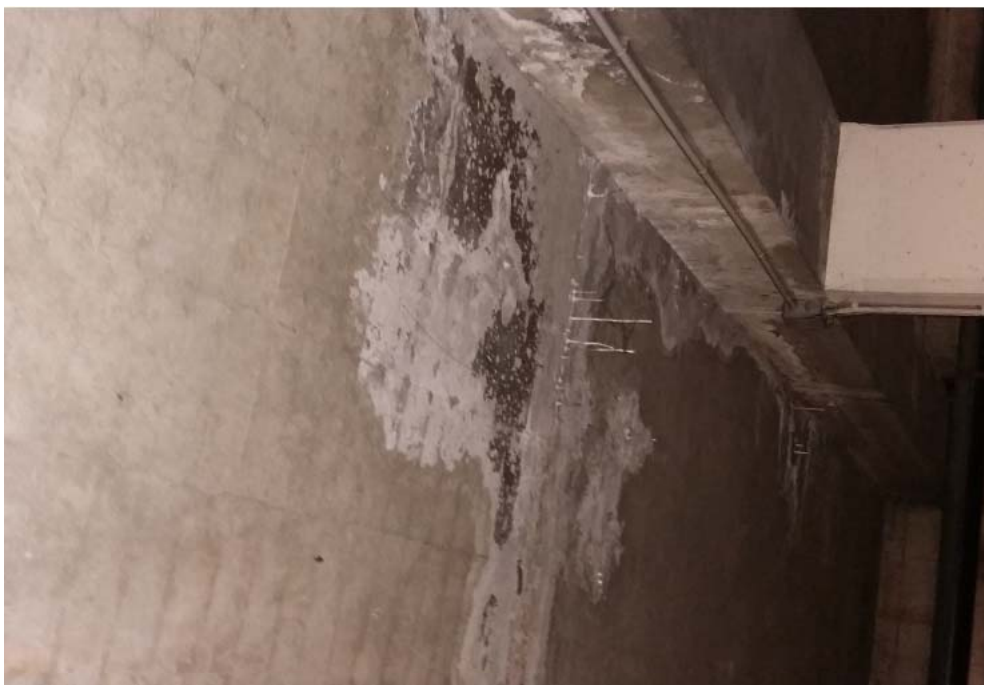
Constats de formation de calcite suite aux infiltrations d'eau
