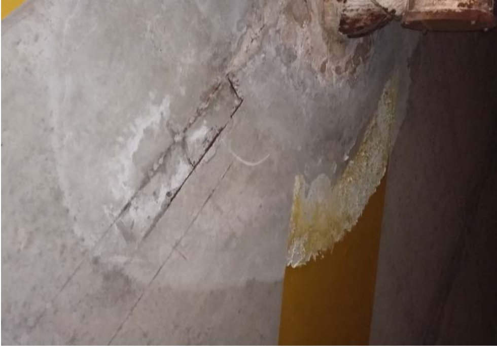
Constat de dégradation des aciers en plafond suite aux infiltrations
