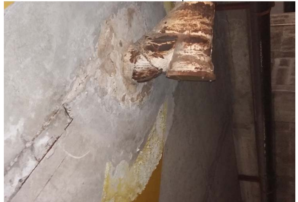
Constat d'éclatement des béton par la corrosion des aciers provoquée par les infiltrations d'eau
