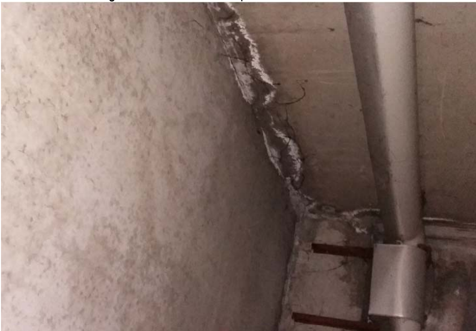
Constat de formation de calcite suite aux infiltrations d'eau
